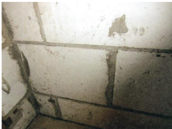
Abbildung 21 Materialbedingte Wärmebrücke durch Mauerfugen
